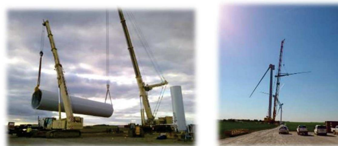
Illustration 11 : montage des éléments du mat (à gauche) et du rotor « pale par pale » (à droite)
